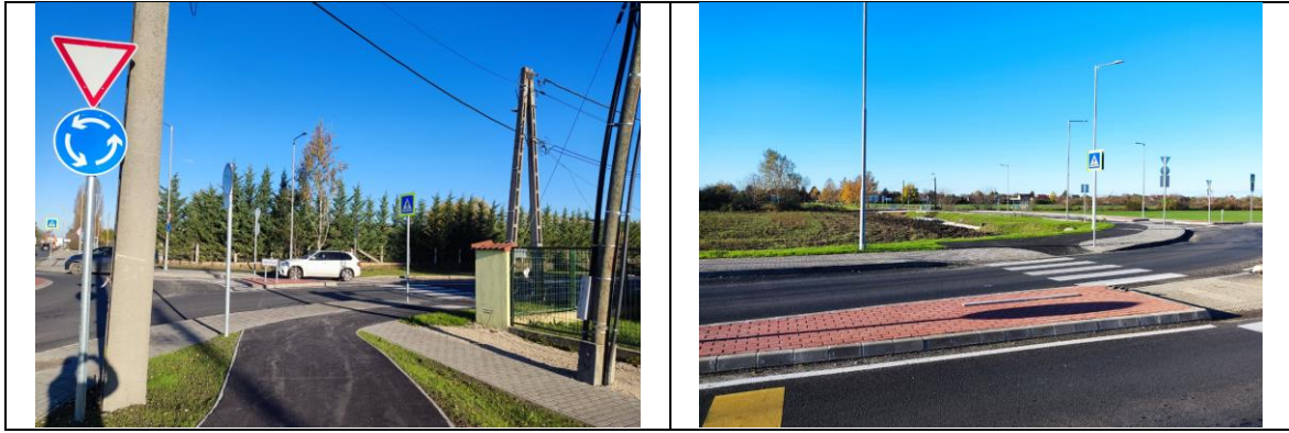
A megépült körforgalom Vadlúd utcai csatlakozása, valamint a Sós-kúti út és a Rákóczi út sarka (saját fotó)
