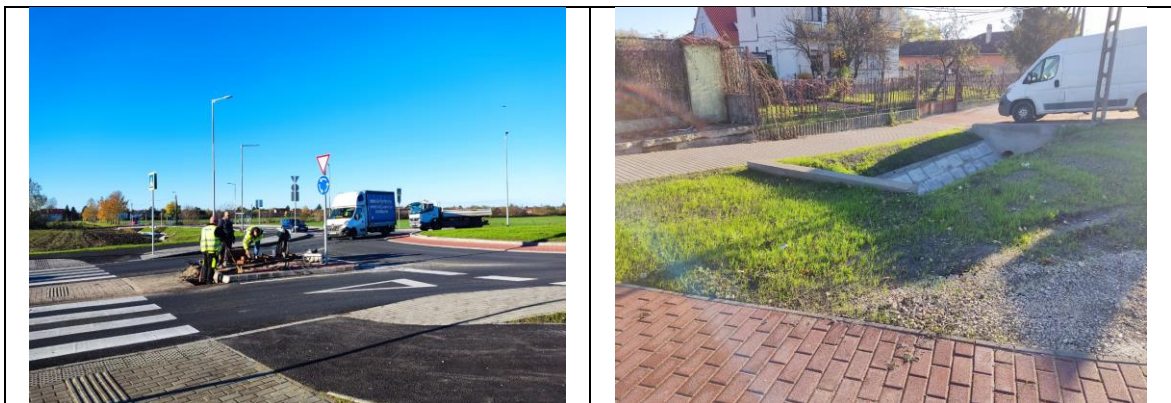
Utómunkálatok és a Sós-kúti út mellett kiépült árok (saját fotó)
