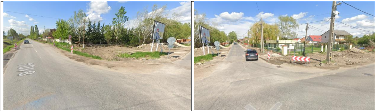
A Sós-kúti út és a Vadlúd utca találkozási pontja a csomópont építés kezdetén (Google maps)
