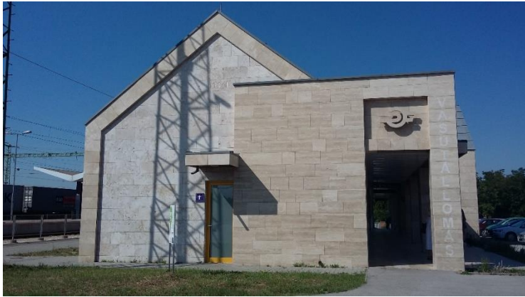
A vasútállomás modern megjelenésű új épülete és az elbontott régi állomás-épület képe Az épület tervezésének ideje: 2010–11 Tervező: Bánszky Szabolcs, Mata-Dór Építésziroda
