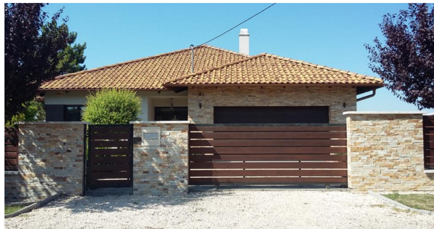
A mai kor jellegzetes épülettípusát követő családház a Hazatérők útján
