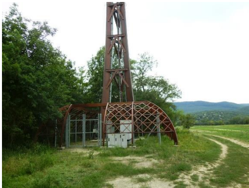
Fa főszerkezetű telefon átjátszó torony a Szentendrei-szigeten, a Tahitótfalui temető mellett http://static.panoramio.com/photos/large/76947554.jpg
