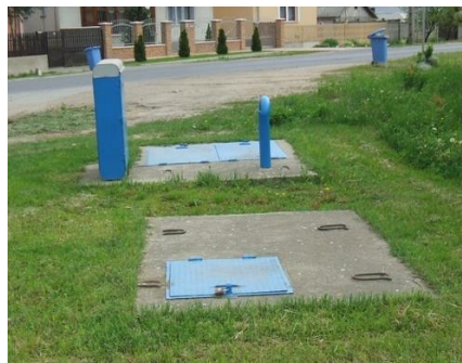
Szennyvízátemelő föld alatti kialakítással
