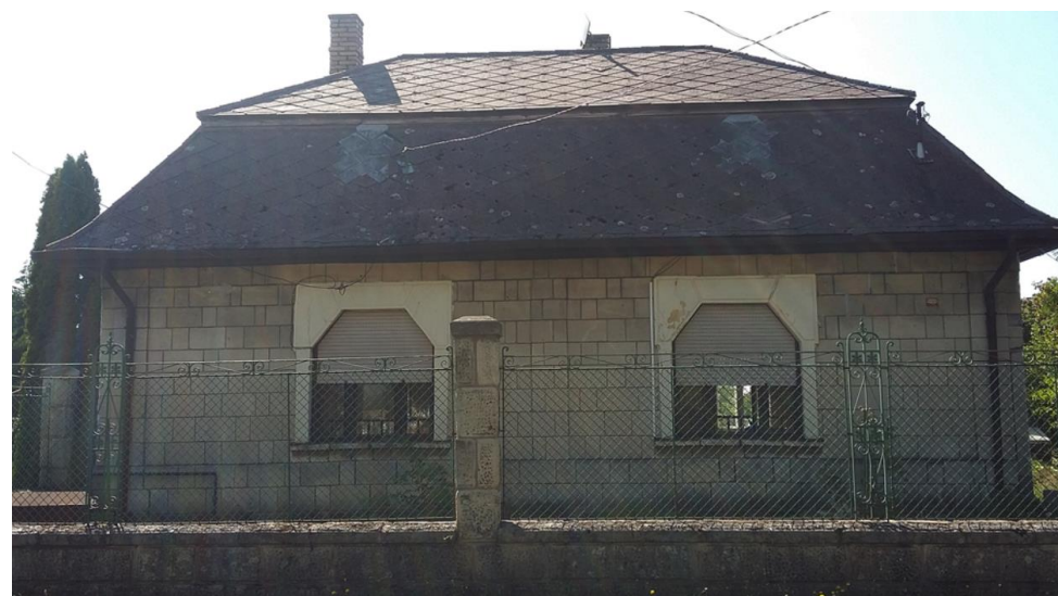
Manzárd tetős lakóépület az Ősz utcában
