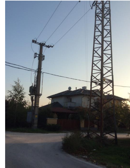
Oszloptranzformátorok, távvezeték tartó oszlopok a belterületen
